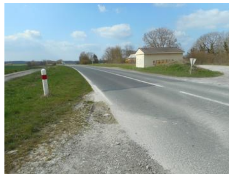
Fig. 45 b : visibilité à gauche avant de la RD 1032
